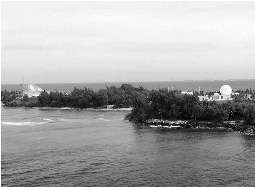
写真4 クワジェリン島のレーダードーム
